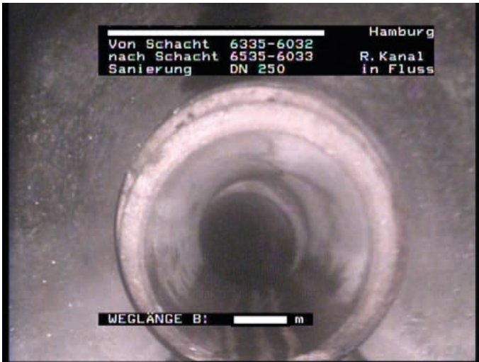
Reparaturergebnisse von Rohrversätzen und Lageabweichungen mit Pipe-Seal-Flex. Hier: vor der Reparatur.
